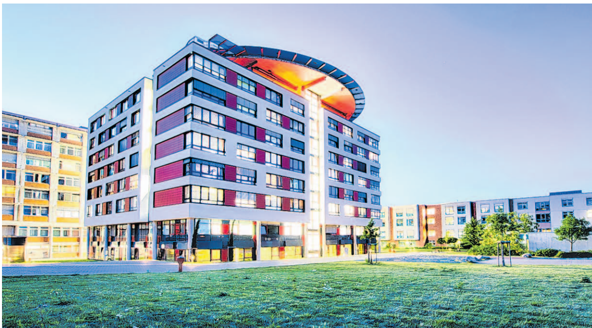
Der 32m hohe Neubau des Rhein-Maas Klinikums beherbergt 240 Betten.
